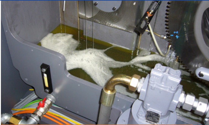
FÜR DEN UMLAUF WIRD DAS ÖL IM SUMPF JEDER DRUCK-EINHEIT GESAMMELT und mittels einer Ölpumpe durch Feinfilter wieder in den Kreislauf gepumpt.
